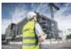
Inspeção industrial e de edifícios
